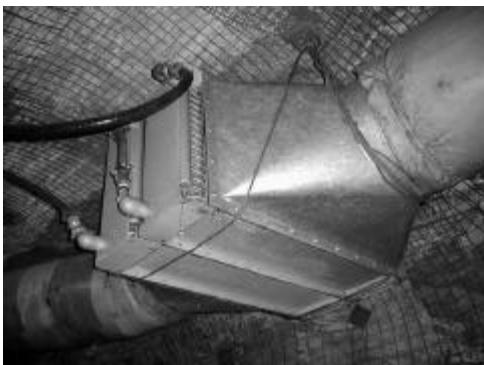
図 4 プレートフィンコイル
