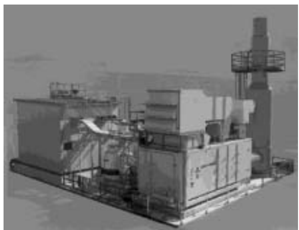
図 4 パイロットプラント外観写真
