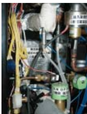
Photo 2 熱交換器部の拡大
