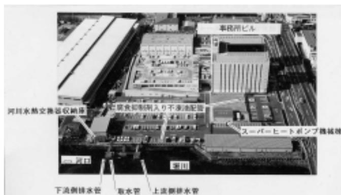
図2 河川水利用スーパーヒートポンプシステム
