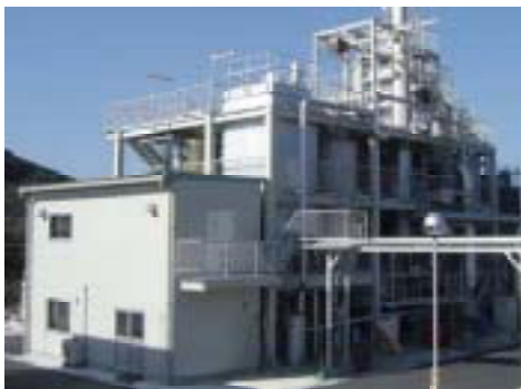
図9 鹿児島県市来町廃棄物ガス化発電施設
