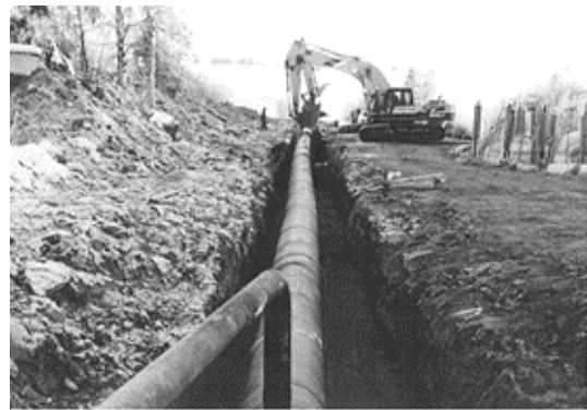
図13 アラスカ州フェアバンクスにおける実大実験（パイプ埋設状況）
