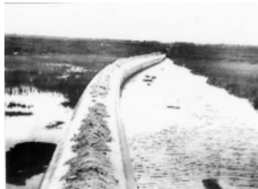
図9 浮上した埋設ガスパイプライン(直径約1.5m)
