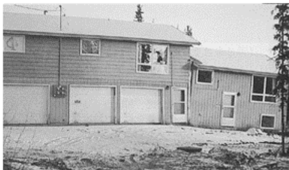
図8 永久凍土融解により生じた不等沈下を受けた家屋(アラスカ州フェアバンクス市)
