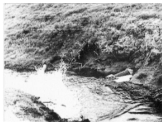
図10 パイプ周囲の凍土が融解し、洗掘され、損傷したパイプからのガス漏洩状況
