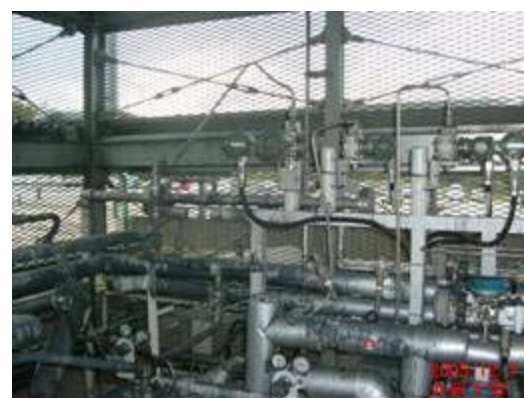
図5 酸素配管の事故前（上）と事故後（下）の状況 [4]
