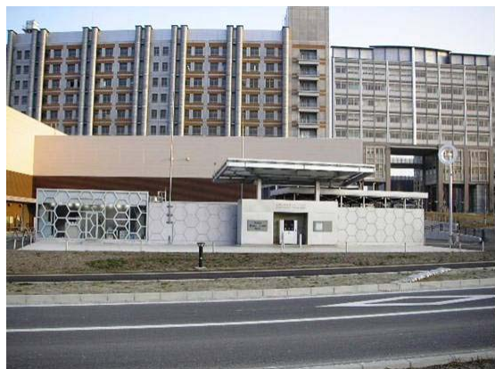
図 1 九州大学水素ステーション[3]
