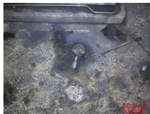
図6 HHEG室内に飛散した圧力計（中央）と配管（右上） [4]
