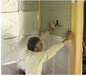
図9 断熱改修の施工状況
