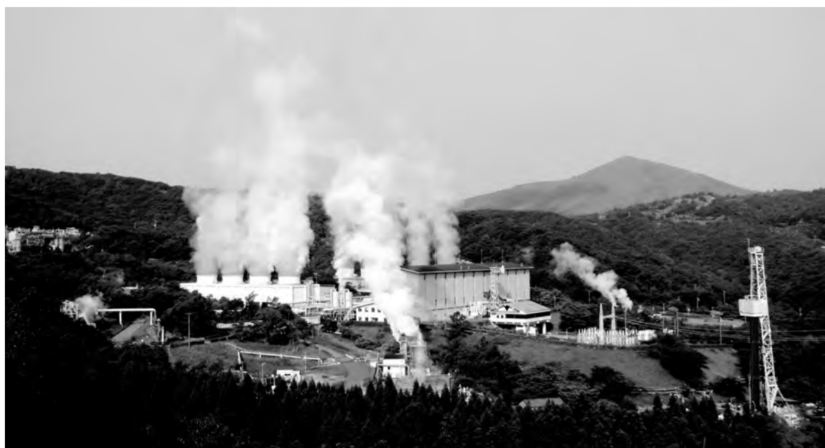
図1 八丁原発電所全景
