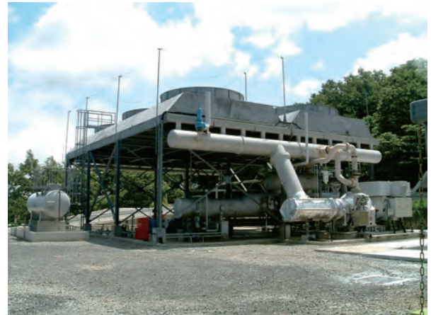
図5 バイナリー発電設備
