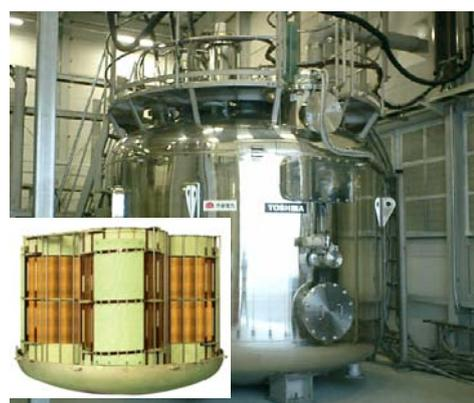
図2 10MVA-SMES エネルギー貯蔵部外観および内部コイル
