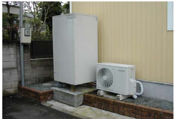
加熱能力 6kW, 貯湯タンク 460ℓ, 2003年モデル
