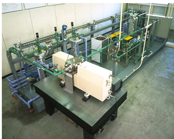
熱出力 6kW, 1996 年設置 図 5 CO 2 ヒートポンプ基礎実験ループ
