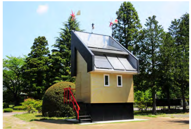
図4 ロハスの家1号 自立共生冷暖房の木の家
