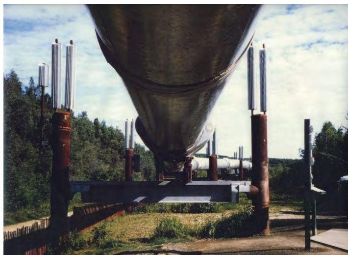
図5 永久凍土融解防止用ヒートパイプ (勝田所蔵写真)
