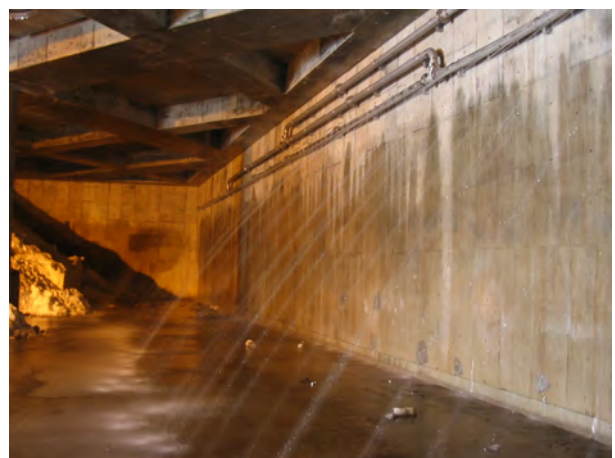
図12 散水実験状況
