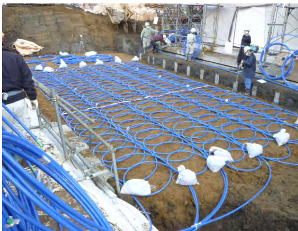
図3 地中熱採熱側コイル敷設状況
