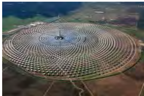
図8 Gemasolar プラント (スペイン南西部) [7]
