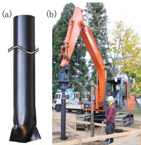
図3 (a) ブレードパイル, および (b) 汎用重機による埋設風景.
