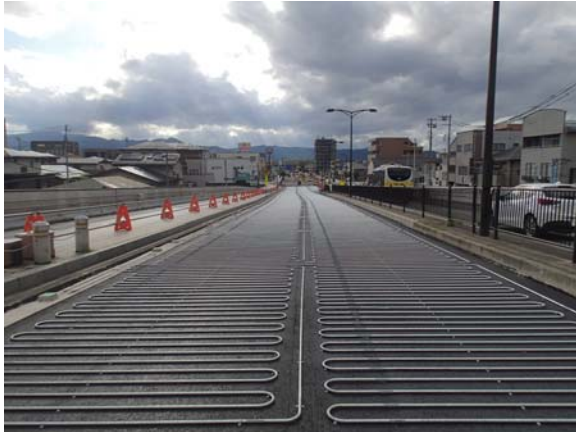
写真 1 鋼管製放熱管敷設状況
