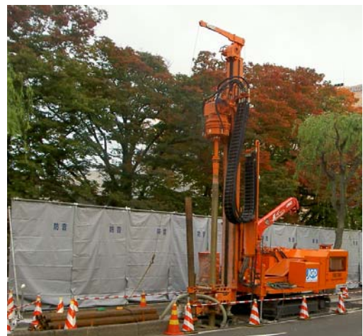
写真4 ソニックドリルによる掘削状況
