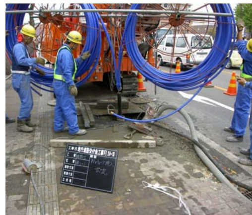
写真5 地中熱交換器(Uチューブ)挿入状況
