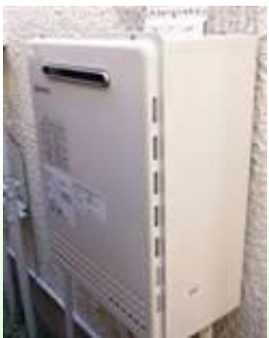
屋外壁掛け給湯器
