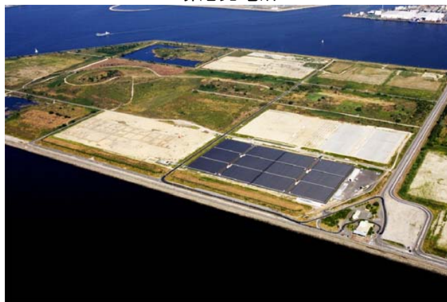
堺太陽光発電所
