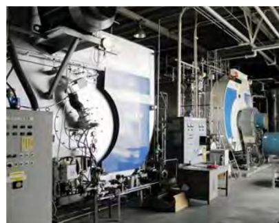
図 4 煙管ボイラーの外観（2 ユニット）
