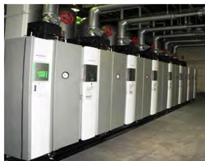
図 3 貫流ボイラーの外観（8 ユニット）
