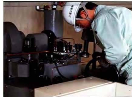
図 15 保守作業の様子
