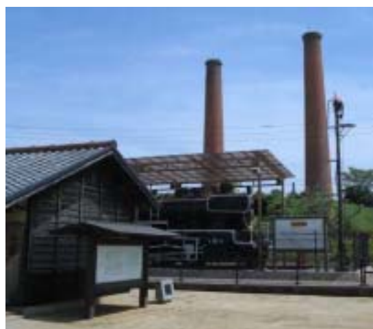
図 3 二本煙突と復元された炭鉱住宅
