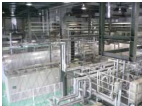
写真4 熔融炭酸塩型燃料電池システム
