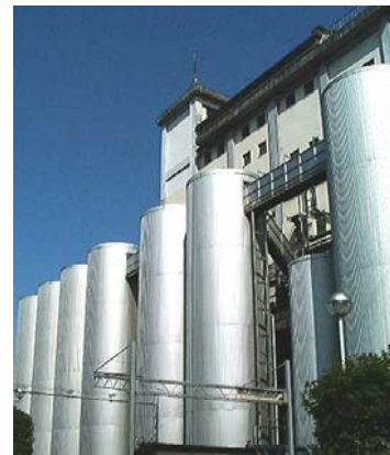
図6 大型発酵タンク
