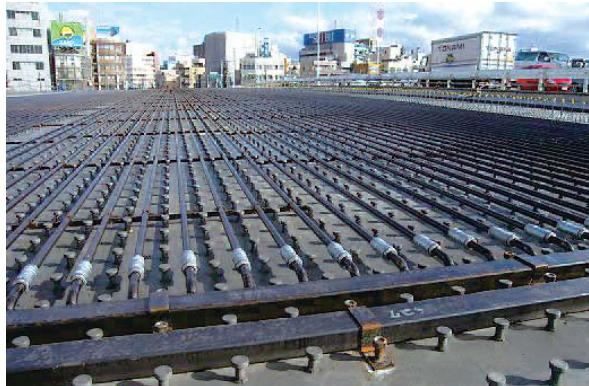
写真3 鋼床版橋での放熱管の設置（幸橋）
