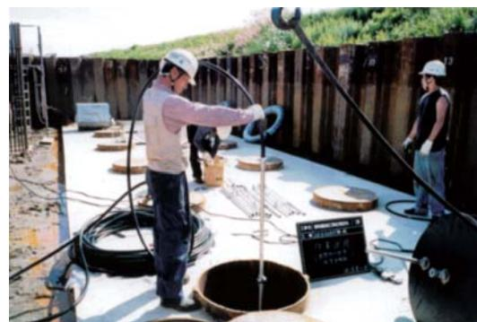
写真2 橋台基礎鋼管杭への送水用ポリ管設置
