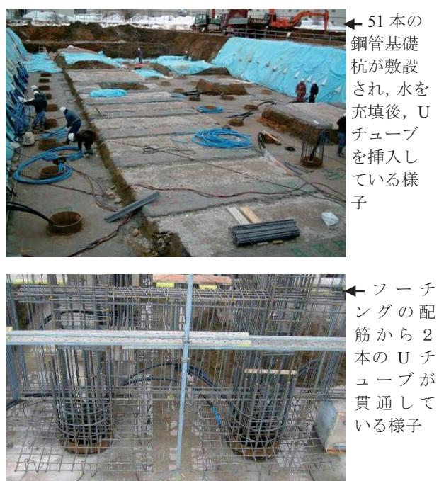
写真3 鋼管基礎杭を利用したGSHPの施工状況
