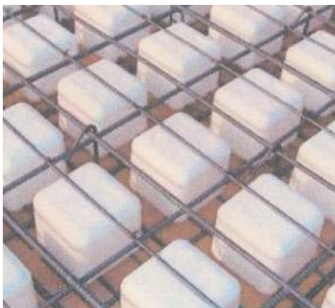
図 8 ボイドスラブの構造例
